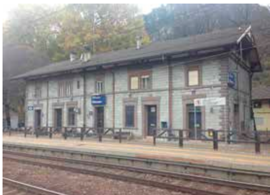
Bahnhof wird saniert - risanamento della stazione approvato
